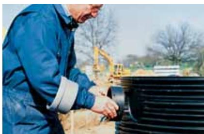
2. В высверленном отверстии установить прокладку и смазать её силиконовой смазкой.
