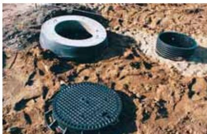
11. В состав элементов, венчающих конструкцию колодца, кроме пластмассовой конической горловины входят бетонное разгрузочное кольцо и чугунный люк. Чтобы предохранить чугунный люк от перемещений во время последующих работ, необходимо его забетонировать по разгрузочному кольцу или произвести анкеровку.
