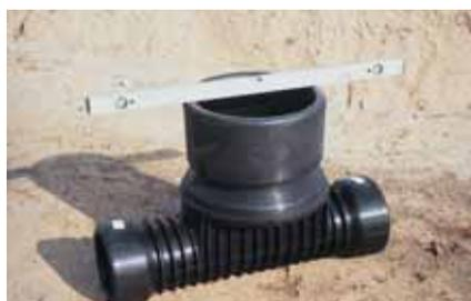
2. Лотковая часть горизонтально укладывается на 5–10 см слой неуплотненной песчаной подсыпки, представляющей собой выравнивающий слой дна котлована. Для подсыпки и засыпки мы можем использовать местный грунт при условии соблюдения требований, выдвигаемых в отношении песчаных подсыпок и обсыпок. При выравнивании лотковой части необходимо помнить о встроенном уклоне дна, равном 1,5%. В пропускных основаниях стрелка показывает правильное направление течения сточных вод.
