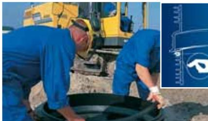
4. Днище необходимо уложить на заранее подготовленную песчаную подсыпку и выровнять. Лотковую часть, оснащенную раструбами и уплотнительными кольцами, необходимо подсоединить к гладким концам канальных труб. Затем установить прокладку, предварительно очистив паз.
