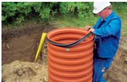
5. Затем в наиболее низко расположенный паз снаружи трубы необходимо установить уплотнительное кольцо для гофрированной трубы, поставляемое вместе с лотковой частью.
