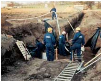
получены данные по влиянию статических нагрузок от грунта (в том числе о действии подъемной силы грунтовых вод), а также динамических нагрузок на поведение колодца «Тегра 1000» (изучение деформаций и герметичности конструкции колодца).
