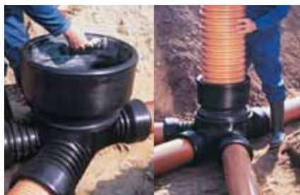
5. Раструб лотковой части необходимо очистить от загрязнений и смазать силиконовой смазкой. Установить шахтную трубу в раструбе дна колодца посредством вдавливания. Выполненное соединение является герметичным. Заглушку, вынутую из раструба дна колодца, необходимо установить наверху гофрированной трубы с целью предохранения сооружаемой канализационной сети от загрязнений в ходе последующей сборки.
