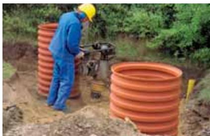
8. Засыпка котлована производится слоями. Песчаная обсыпка равномерно уплотняется по всему периметру колодца. Необходимо обеспечить степень уплотнения грунта, которая соответствовала бы имеющимся грунтово-водным условиям, а также последующей внешней нагрузке. Рекомендуется применение уплотнения грунта на уровне минимум (SP – Стандартный Проктор):
