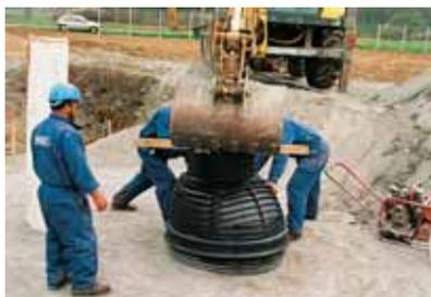
10. Коническая горловина монтируется таким же образом, как и остальные элементы колодца, необходимо помнить о том, что при использовании ковша экскаватора элемент из пластмассы необходимо предохранять с помощью деревянной проставки.
