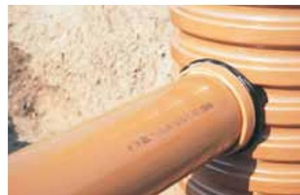
3. Установленная таким образом муфта in situ готова для помещения в неё гладкостенной канализационной трубы из ПВХ.
