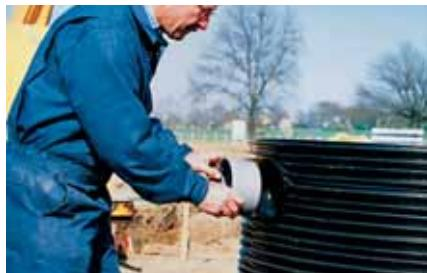
1. Специальной фрезой в стенке удлинительной части колодца (шахте) выполняется отверстие таким образом, чтобы оно с монтажным раствором не мешало другим элементам. Высверленное отверстие очистить от заусенцев.
