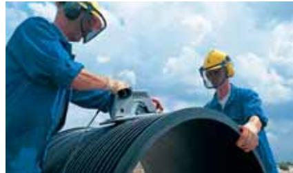
6. Сборку (соединение) отдельных элементов можно выполнить с помощью специального монтажного инструмента или ковша экскаватора, применяя деревянную пропставку.
