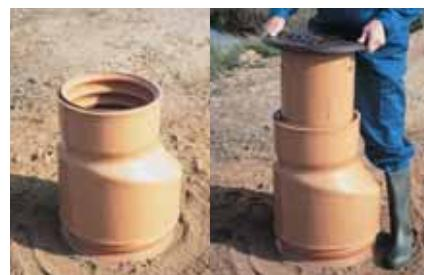
8. Уплотнительное кольцо смазать силиконовой смазкой и установить люк. Установить положение верха люка или дождеприёмника соответственно отметки на местности.
