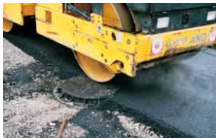
10. Коническая горловина монтируется таким же образом, как и остальные элементы колодца, необходимо помнить о том, что при использовании ковша экскаватора элемент из пласти массы необходимо предохранять с помощью деревянной приставки.
