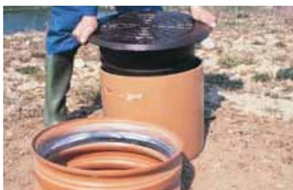
7. В случае применения чугунных люков с телескопическим адаптером, поставляемое вместе с ними уплотнительное резиновое кольцо (для гофрированной трубы) необходимо установить в наиболее высоко расположенном желобке внутри гофрированной трубы. Выполнить соединения люка или дождеприёмника с телескопической трубой (механическое соединение на защёлку).
