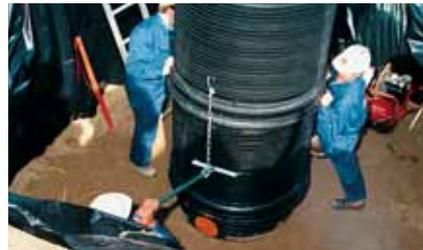
6. Сборку (соединение) отдельных элементов можно выполнить с помощью специального монтажного инструмента или ковша экскаватора, применяя деревянную проставку.
