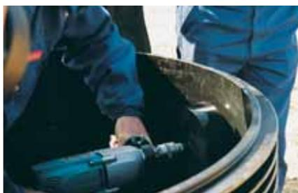
1. Специальной фрезой в стенке удлинительной части колодца (шахте) выполняется отверстие таким образом, чтобы оно с монтажным раструбом не мешало другим элементам. Высверленное отверстие очистить от заусенцев.
