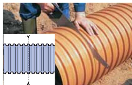
3. Гофрированную трубу (шахту) подрезают до требуемой высоты на строительной площадке. Для её подрезки достаточно ручной пилы. Необходимо помнить, что резку нужно осуществлять посередине гофры (не желобка)! Высота гофрированной трубы должна быть больше проектной на 20–30 см. Излишки обрезаются по уровню грунта после полной засыпки и уплотнения.
