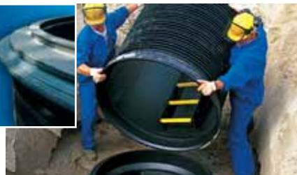
3. При глубоких котлованах, а также при транспортировке на строительной площадке необходимо пользоваться подъёмным оборудованием. Делать это позволяют специальные проушины, которыми оснащены все элементы колодца.
