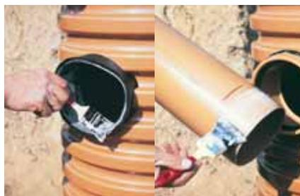
2. Установить в высверленном отверстии специальную прокладку и смазать её силиконовой смазкой. В отверстие, подготовленное таким образом, необходимо установить специальный раструб in situ.
