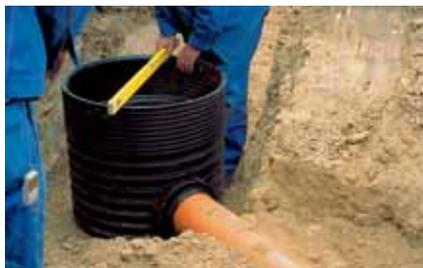
2. Лотковую часть колодца необходимо уложить на заранее подготовленную песчаную подсыпку. Подсоединить канализационные трубы, точно устанавливая угол подсоединения труб (диапазон регулировки  $\pm 7,5^\circ$ ). Верх лотковой части необходимо выровнять.
