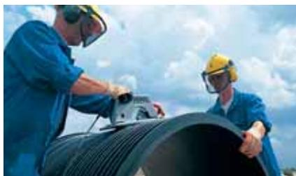
8. С целью получения требуемой высоты колодца стандартную высоту средней части можно укоротить. Укорочение можно произвести с помощью ручной или механической пилы.
