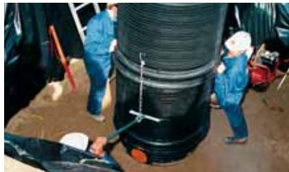
4. Днище необходимо уложить на заранее подготовленную песчаную подсыпку и выровнять. Лотковую часть, оснащенную раструбами и уплотнительными кольцами, необходимо подсоединить к гладким концам канальных труб. Затем установить прокладку, предварительно очистив паз.
