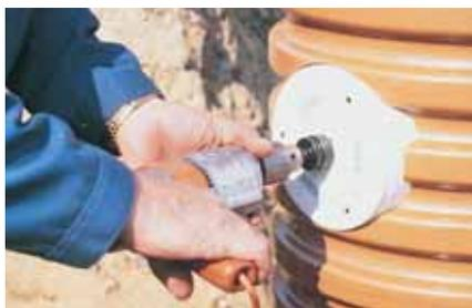
1. Специальной фрезой выполняем отверстие в гофрированной трубе. Очищаем края отверстия от заусенцев.
